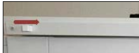
Fällda inåt, ventilen är stängd
