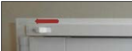
Fällda utåt, ventilen är öppen
